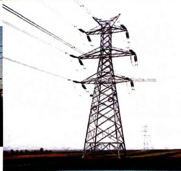
เสาไฟฟ้า
