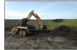
ใช้แบคโฮตักดินตะกอนขึ้นแห้งแล้วขึ้นรถ/เรือบรรทุก
