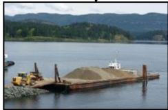
ใช้รถแบคโฮขนตะกอนดินจากเรือ Barge ขึ้นรถบรรทุก
